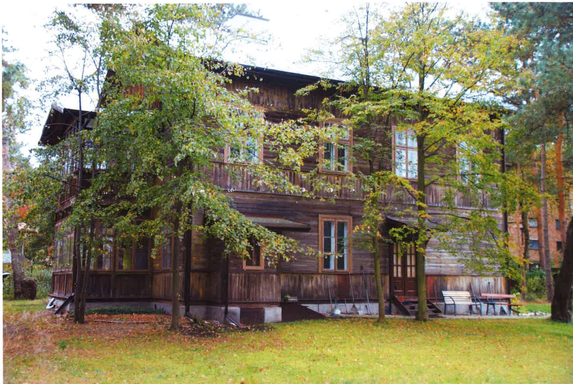
Fot.2. Elewacja północna (tylna) i fragment elewacji wschodniej
