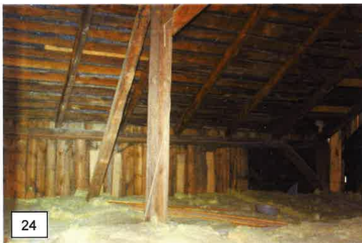
Fot. 22-26. Więźba dachowa
